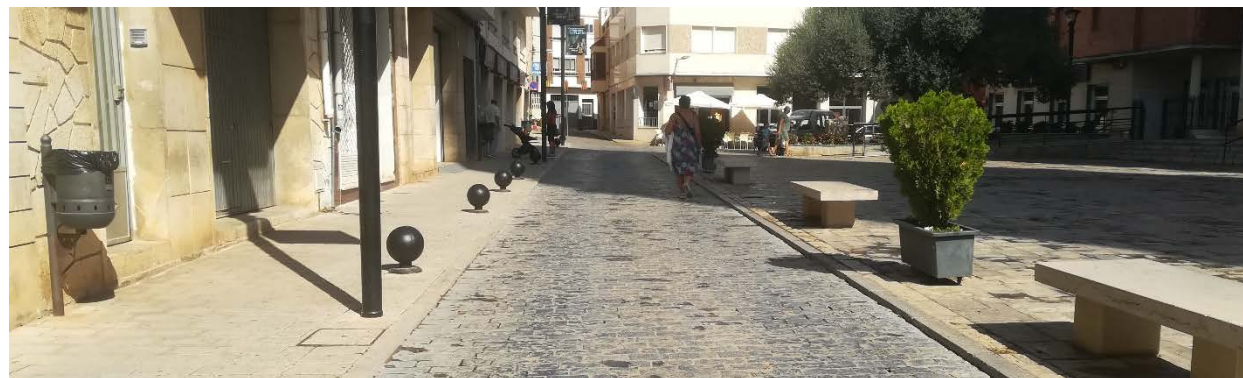
Ilustración 175. Plataforma única junto a plaza peatonal. Plaza de la Iglesia. Fuente. Elaboración propia
