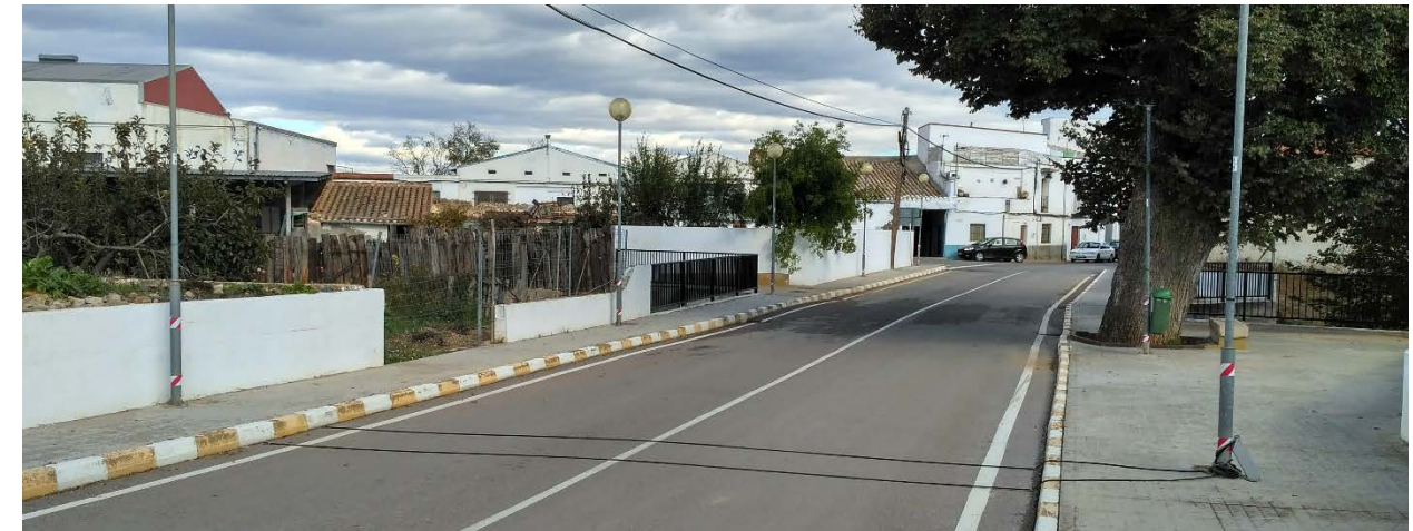
Ilustración 55. Ubicación del aforo en la CV-133. Fuente: Fotografía realizada el día de la colocación de los aforos
