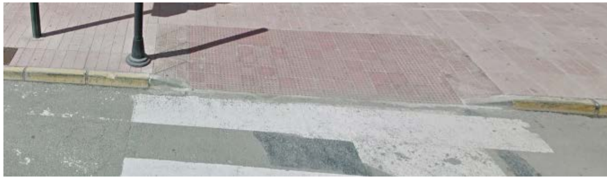
Ilustración 180. Rebajes practicados en aceras junto a pasos peatonales. Fuente: Google Maps.
