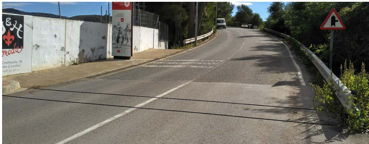
Ilustración 57. Ubicación del aforo en acceso por General Cucala. Fuente: Fotografía realizada el día de la colocación de los aforos
