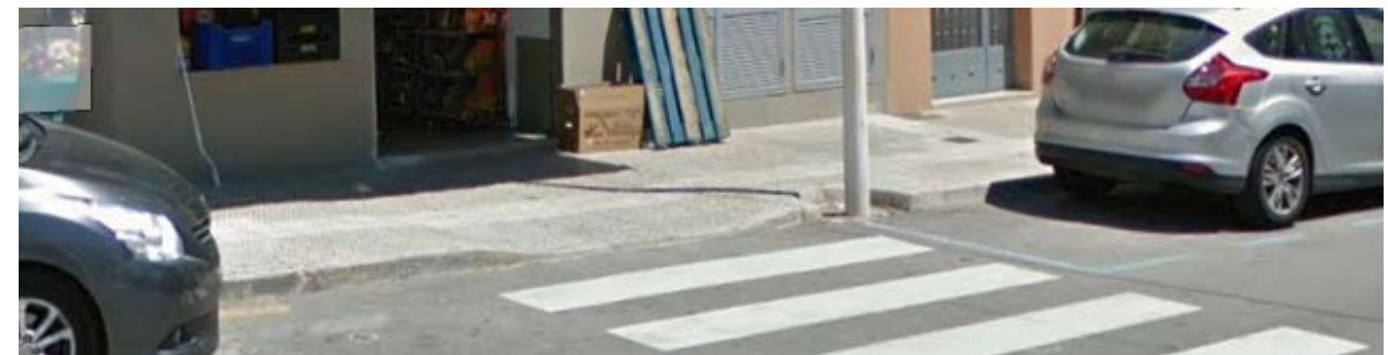
Ilustración 179. Rebajes practicados en aceras junto a pasos peatonales. Fuente: Google Maps.
