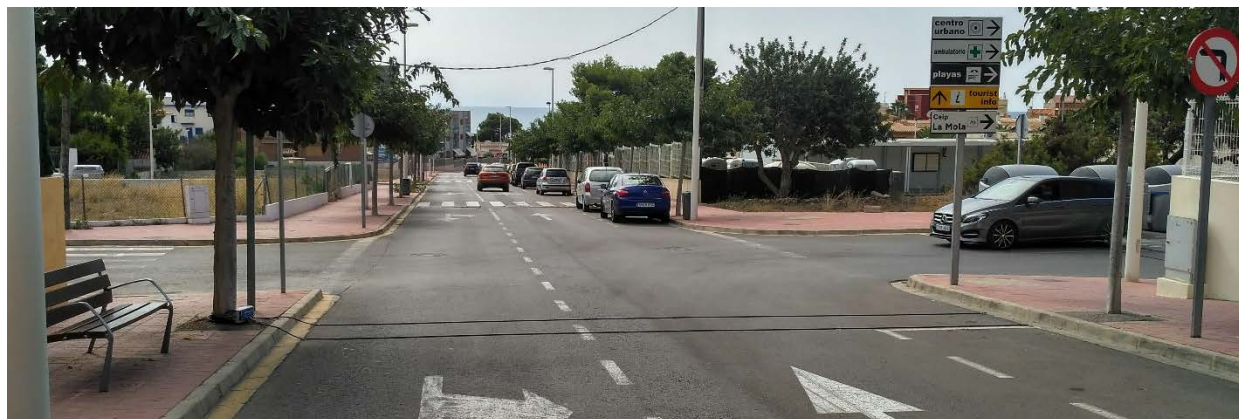
Ilustración 117. Ubicación del aforo en la calle Blasco Ibáñez, en cruce con Serra d'Irta. Fuente: Fotografía realizada el día de la colocación de los aforos
