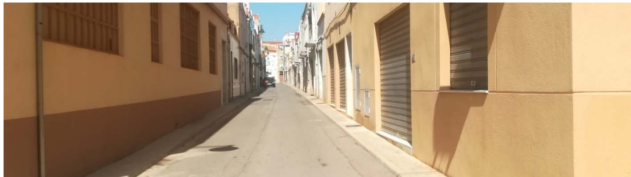
Ilustración 169. Calle Dolors. Vial con aceras inferiores a 1m de anchura. Fuente. Elaboración propia
