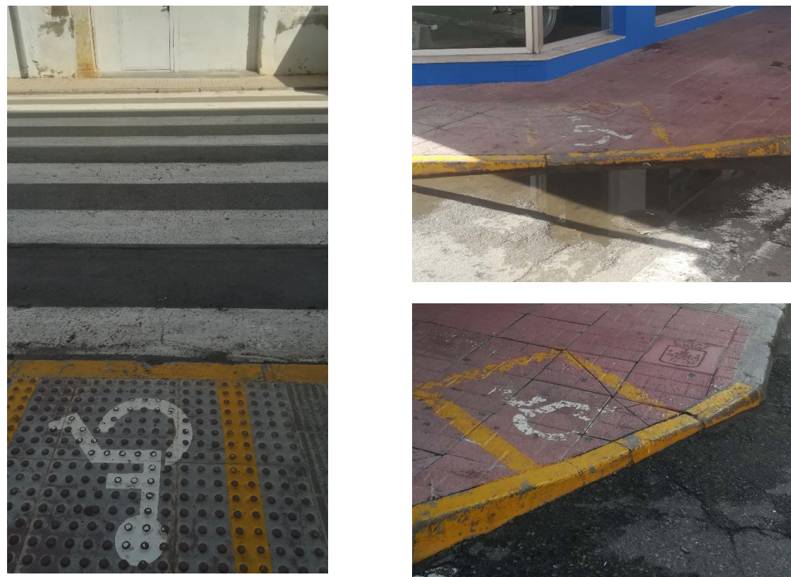
Ilustración 170. Rebajes de acera mal ejecutados en calle Hoya y Passeig Herois del Marroc. Fuente. Elaboración propia
