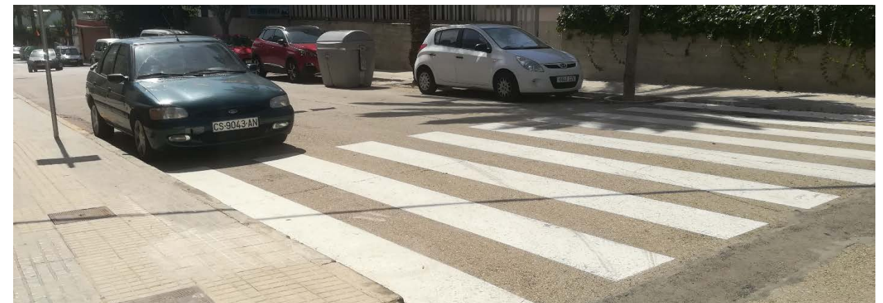
Ilustración 172. Rebajes de acera mal ejecutados en calle Francisco Sospedra. Fuente. Elaboración propia
