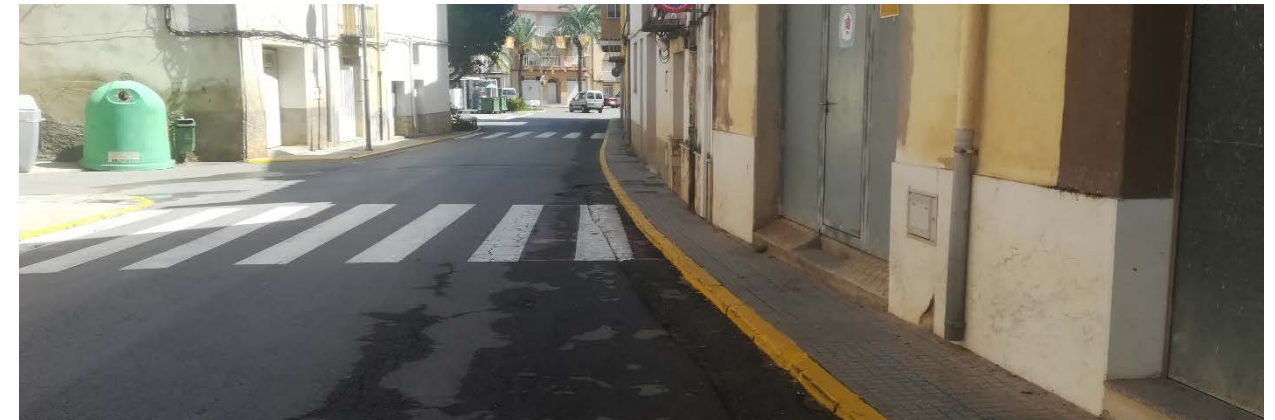
Ilustración 171. Rebajes de acera mal ejecutados en calle Doctor Ebrí. Fuente. Elaboración propia
