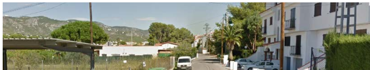
Ilustración 176. Viales sin aceras. Calle Campanilles. Fuente: Google Maps
