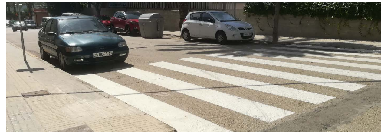
Ilustración 173. Rebajes de acera mal ejecutados en calle Francisco Sospedra. Fuente. Elaboración propia
