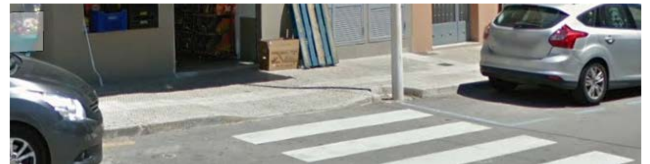
Ilustración 180 Rebajes practicados en aceras junto a pasos peatonales. Fuente: Google Maps.
