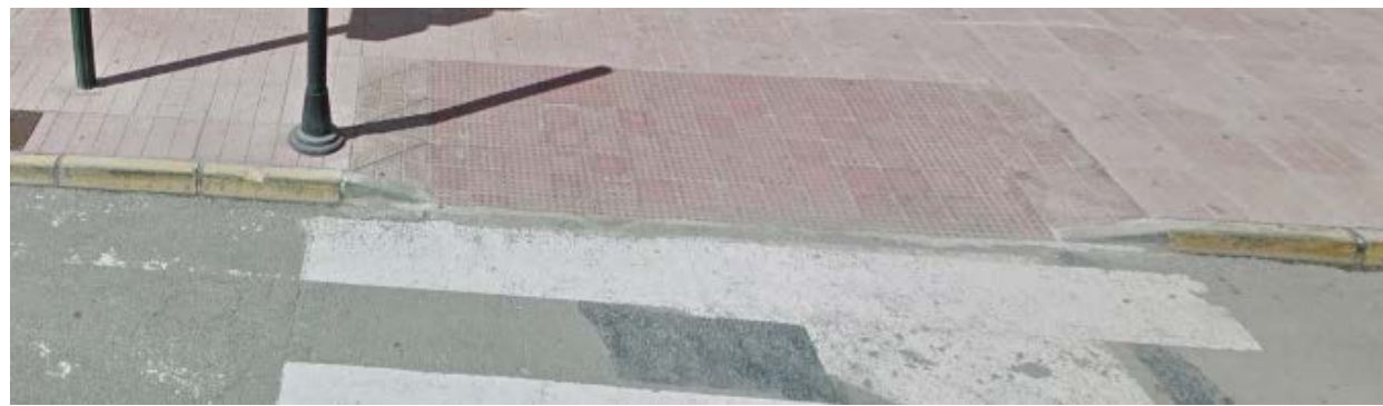
Ilustración 181. Rebajes practicados en aceras junto a pasos peatonales. Fuente: Google Maps.
