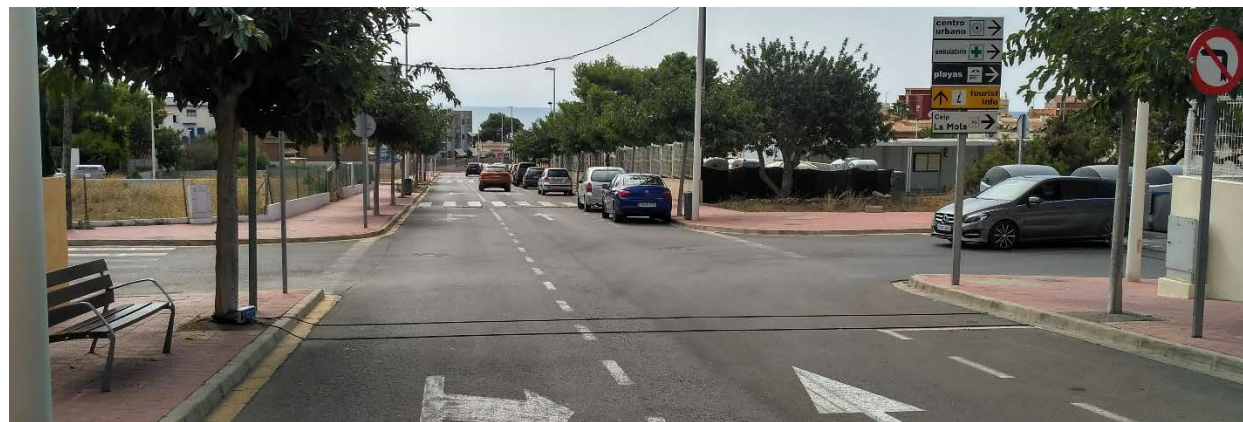
Ilustración 118. Ubicación del aforo en la calle Blasco Ibáñez, en cruce con Serra d'Irta. Fuente: Fotografía realizada el día de la colocación de los aforos
