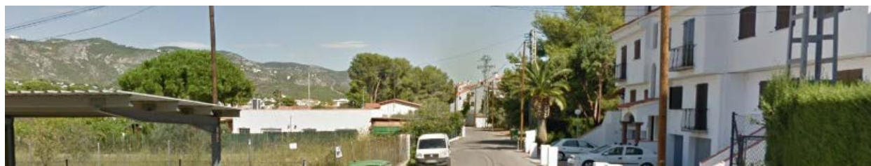
Ilustración 177. Viales sin aceras. Calle Campanilles. Fuente: Google Maps
