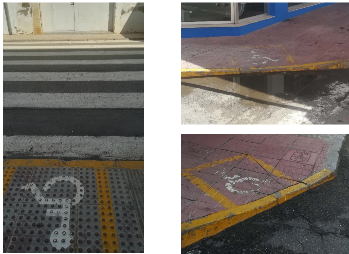
Ilustración 171. Rebajes de acera mal ejecutados en calle Hoya y Passeig Herois del Marroc. Fuente. Elaboración propia
