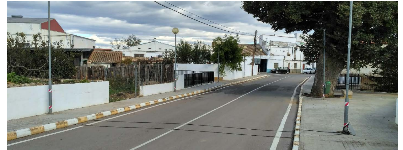
Ilustración 56. Ubicación del aforo en la CV-133. Fuente: Fotografía realizada el día de la colocación de los aforos
