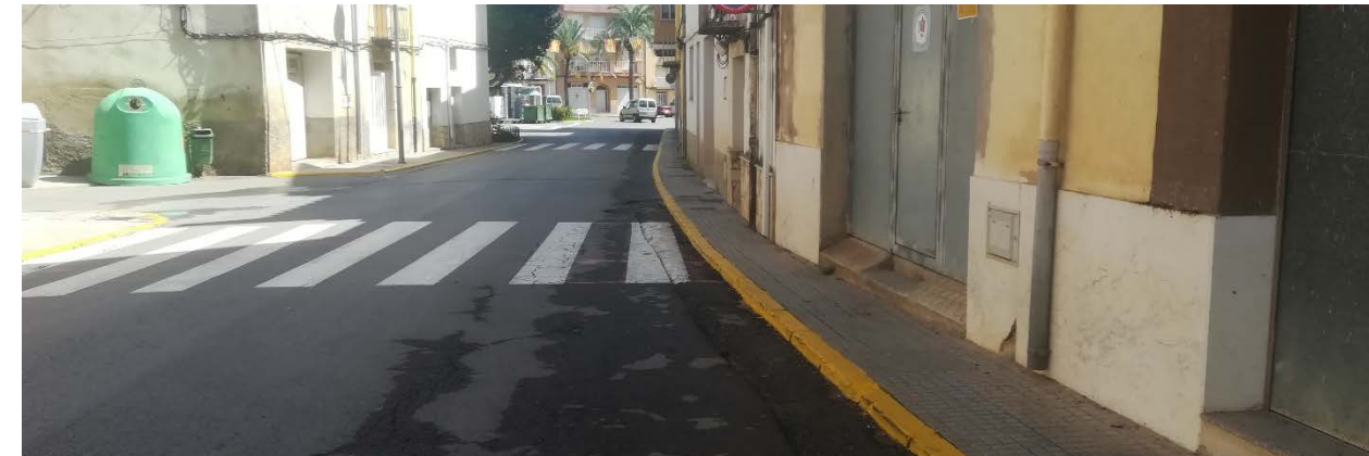
Ilustración 172. Rebajes de acera mal ejecutados en calle Doctor Ebrí. Fuente. Elaboración propia
